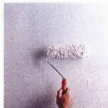
Applicazione protettivo per ambienti umidi
