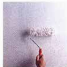
Applicazione protettivo per ambienti umidi
